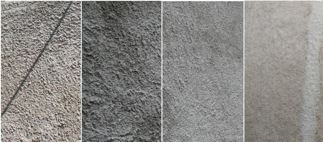
Intonaco recente a base di materiale inerte e legante cementizio (probabilmente con cemento e calce in cui il cemento è prevalente rispetto alla calce).
