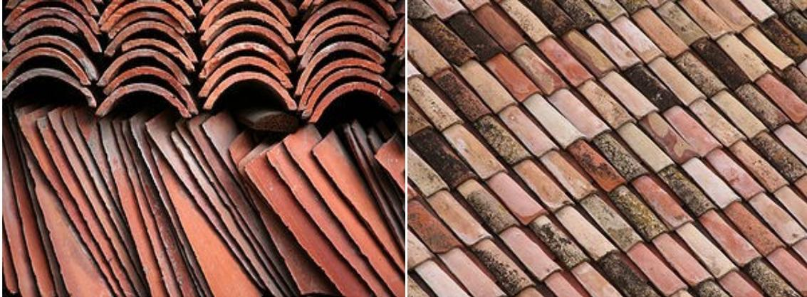
Gli abitati di Bondone, Baitoni superiore ed inferiore sono caratterizzati da coperture realizzate con tegole in laterizio a coppo, con la disposizione di coppi composta da filari concavi e convessi alternati e sovrapposti.
