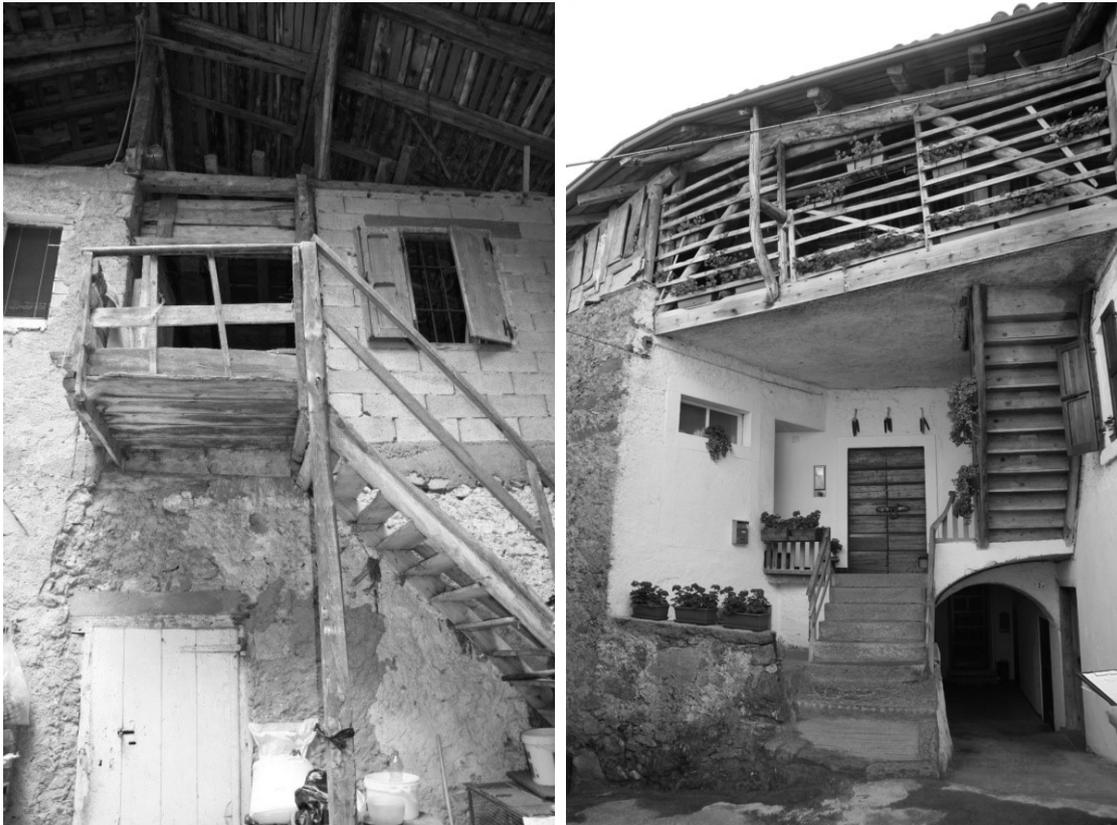
Le scale esterne in legno sono realizzate per permettere l'accesso alle parti del piano primo e del sottotetto partendo dal piano terra o dal piano rialzato.
