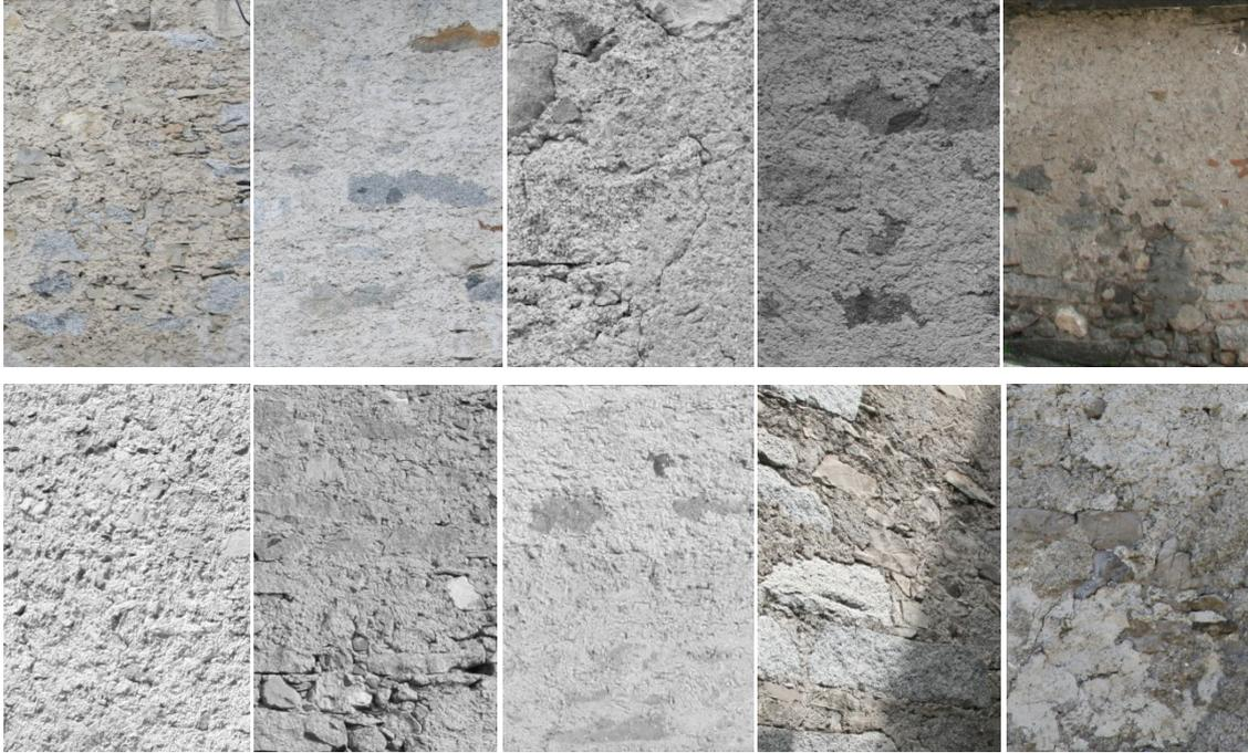
La cortina muraria esterna degli edifici è realizzata con malta di calce tirata a frattazzo di legno, che presenta un aspetto rugoso caratteristico e che in molti casi lascia a vista i sassi dell'apparecchiatura muraria portante «finitura a raso sasso», che non coincide con la stillatura del giunto a mano per mezzo di strumenti in legno.
