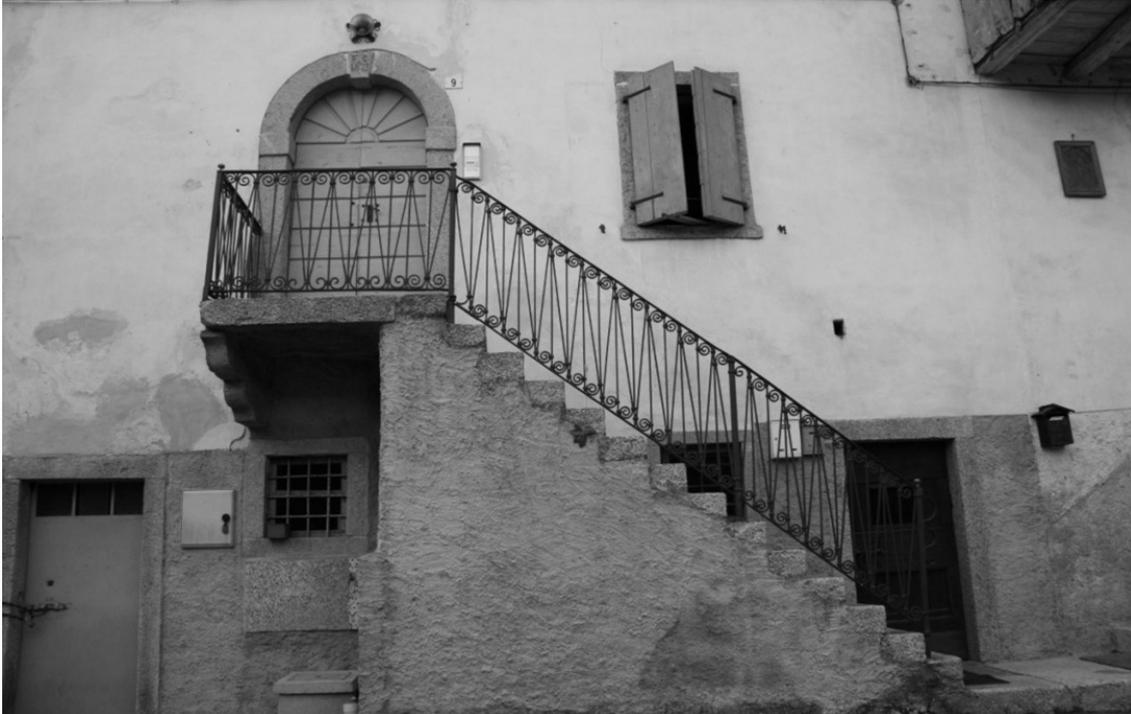
Le scale esterne in pietra sono realizzate per permettere l'accesso agli edifici esclusivamente al piano primo, del piano rialzato o per il superamento dei dislivelli naturali del terreno.
