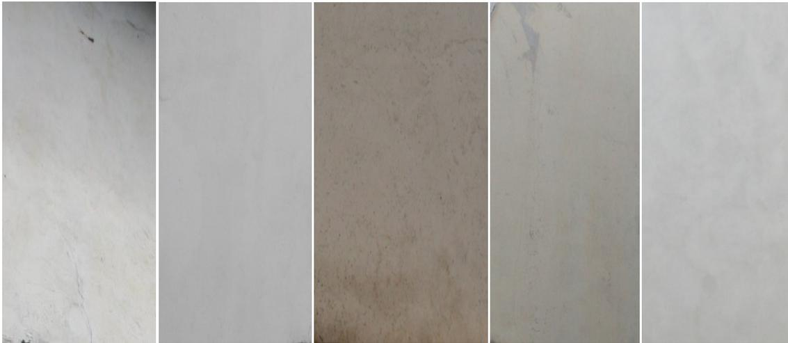
È lo strato di malta, a base di calce aeree o idrauliche naturali ed inerti, a volte colorato in pasta con inerti o pigmenti, di spesso ricompreso generalmente tra 2 e 5 mm, utilizzato molto spesso come finitura dell'intonaco o di un paramento opportunamente predisposto.
