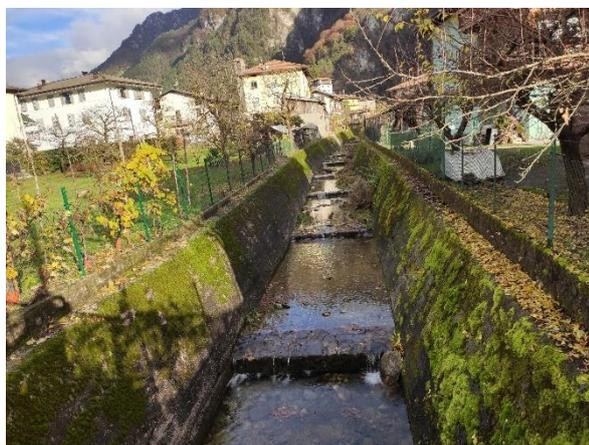
6 – Viste del tratto del Rio Olte che attraversa il centro abitato di Baitoni Inferiore. A valle del ponte di via Frati l'alveo del corso d'acqua si presenta largo e ben incassato tra le protezione spondali realizzate a ridosso delle abitazioni.
