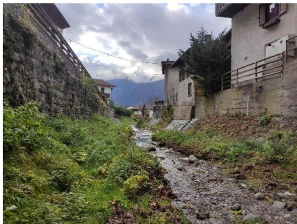
5 – Viste del tratto del Rio Olte che attraversa il centro abitato di Baitoni Inferiore. A partire da poco a monte del centro edificato il corso d'acqua è sistemato con un selciatoone di fondo realizzato con grossi massi cementati e delle murature arginali consolidate negli anni 2016-2017.
